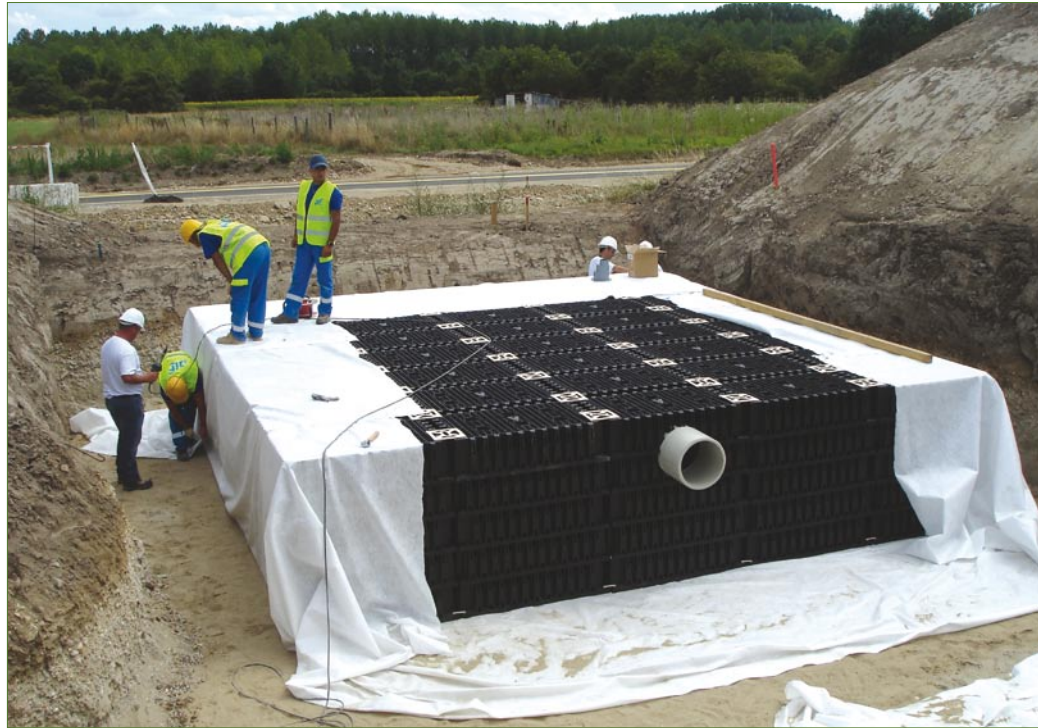
Bassin de rétention des eaux de type Waterloc de chez Nicoll installé sur le site de SAS à Frontonas.
