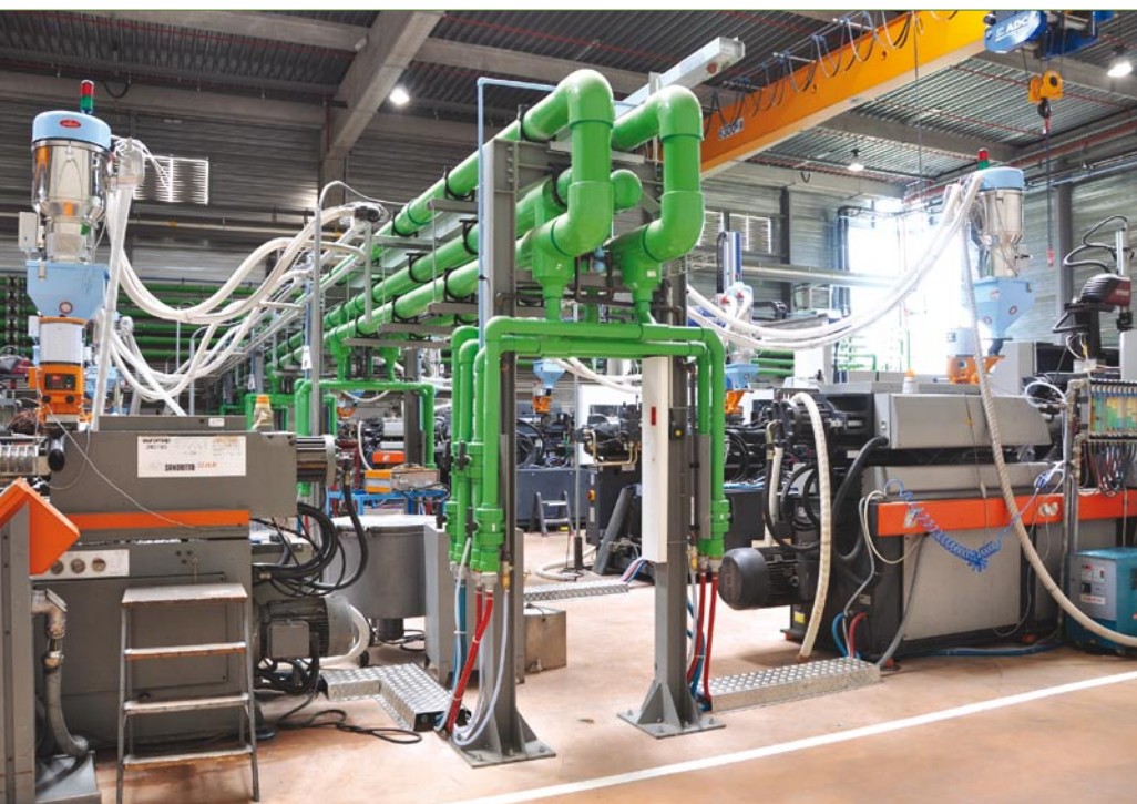
Le système de récupération des calories générées par le refroidissement des presses à injecter permet de stocker l'énergie pour chauffer les bâtiments l'hiver.
